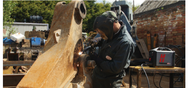
Underhåll och reparationer
